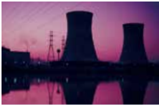
电力工程和输配电
